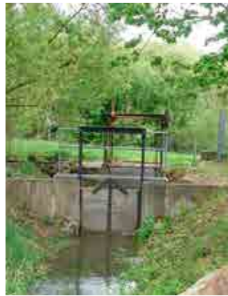
Abb. links: Beim Steckschütz wird eine Holzplatte (Schütz) von Hand in einen fest oder temporär im Graben verankerten Rahmen eingesetzt – ein System, das, abhängig von der verfügbaren Wassermenge, immer angepasst werden muss.
