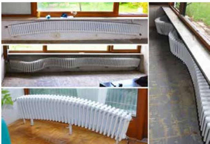
In diesem leerstehenden Gebäude sind die Heizkörper eingefroren und wurden deformiert.
